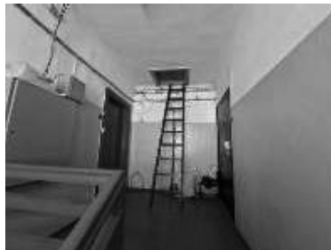
2.stāva kāpņu telpa
